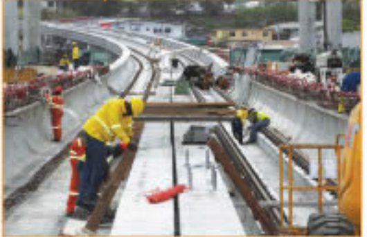
Colocación de los rieles en la estación de Pueblo Nuevo.
