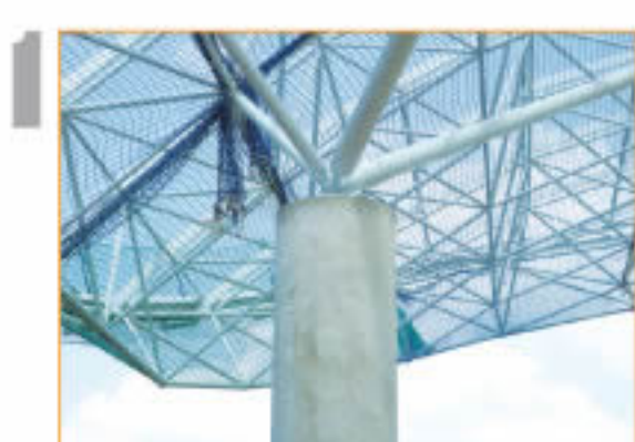
1 Estructura de soporte de las vigas del techo
